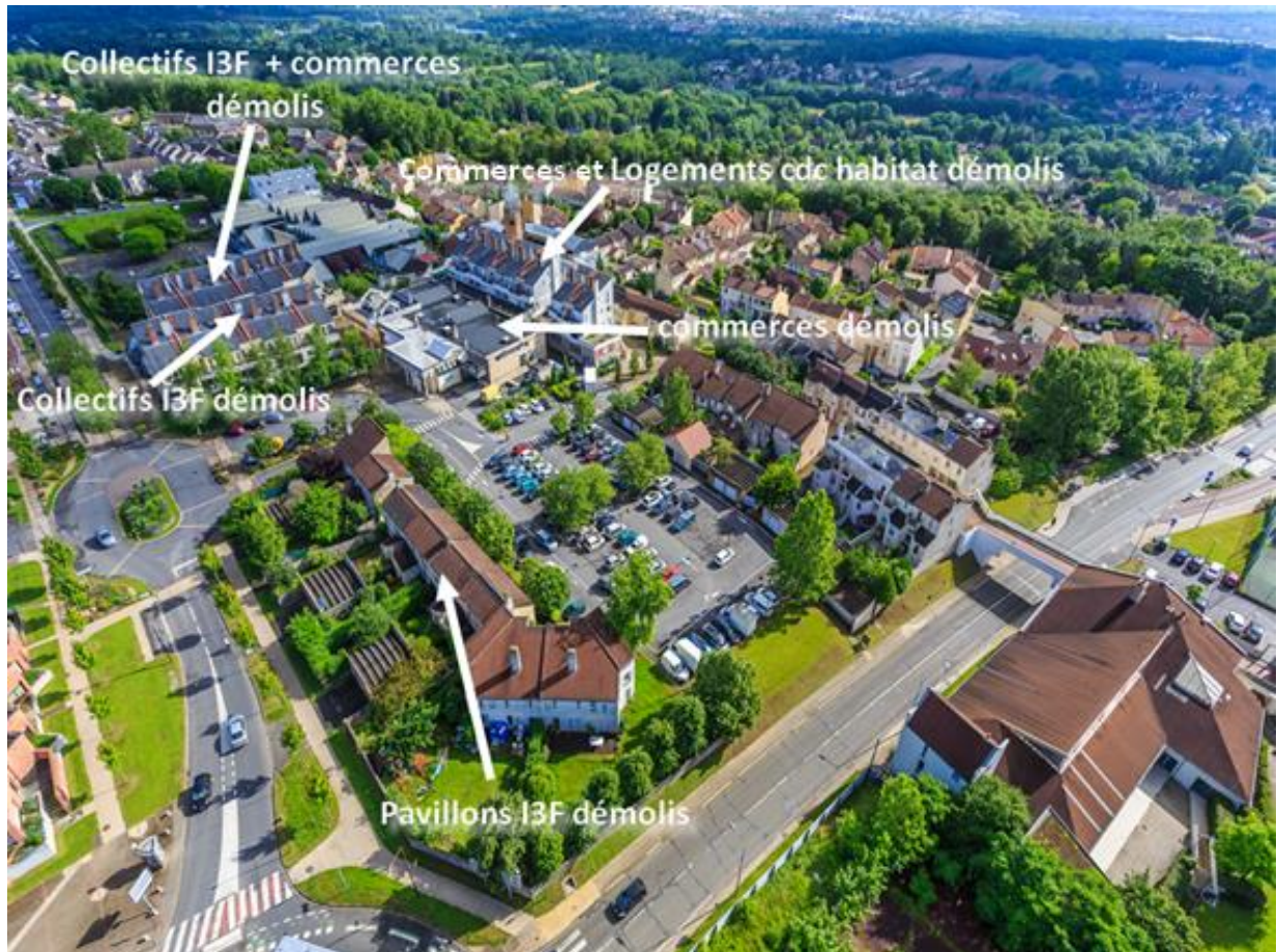
Perspective existante du quartier des Eguerets : démolitions envisagées
