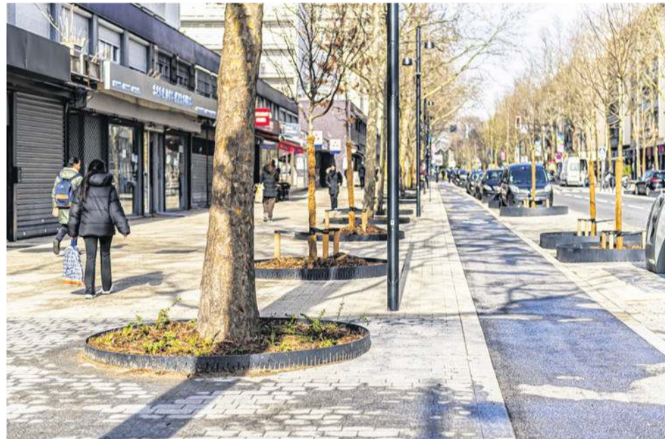
Création de pistes cyclables, installation de bancs, plantations d'arbres et nouveau revêtement de voirie : l'avenue Gabriel-Péri a changé d'aspect. Nicolas Laverroux - Ville d'Argenteuil.
