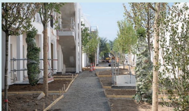
Opération de logements Bouygues Plaine des Linandes à Cergy
