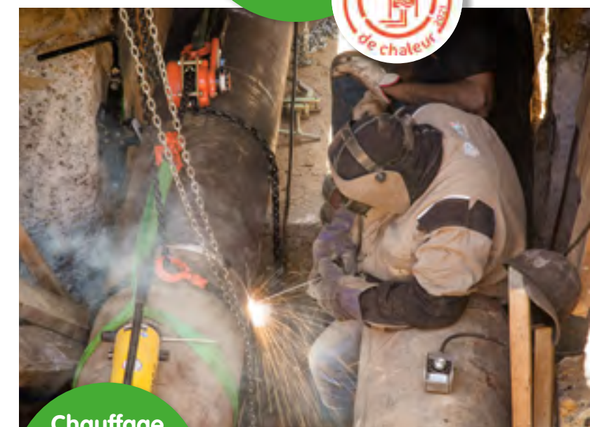
Travaux sur le réseau de chauffage urbain
